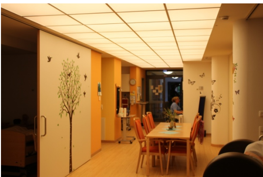
Abb.: Circadianes Beleuchtungssystem der Oase: morgens, vormittags, mittags, abends
